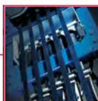
**Courroies en acier à revêtement lisse :** réduisent le bruit du contact métal sur métal des câbles en acier pour offrir un déplacement doux et silencieux.
